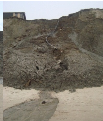
Delvis retablering af nedløb (eget foto april 2012)
